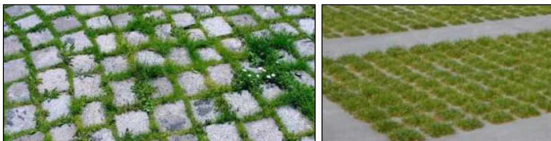
Ex. de traitement de sol limitant l'imperméabilisation
