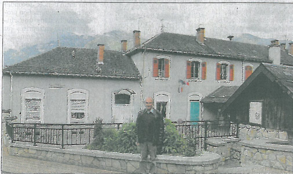
J.F.C. Le chantier de l'école va débiter dès cet été. À terme, maternelle et primaire pourraient être réunis.
